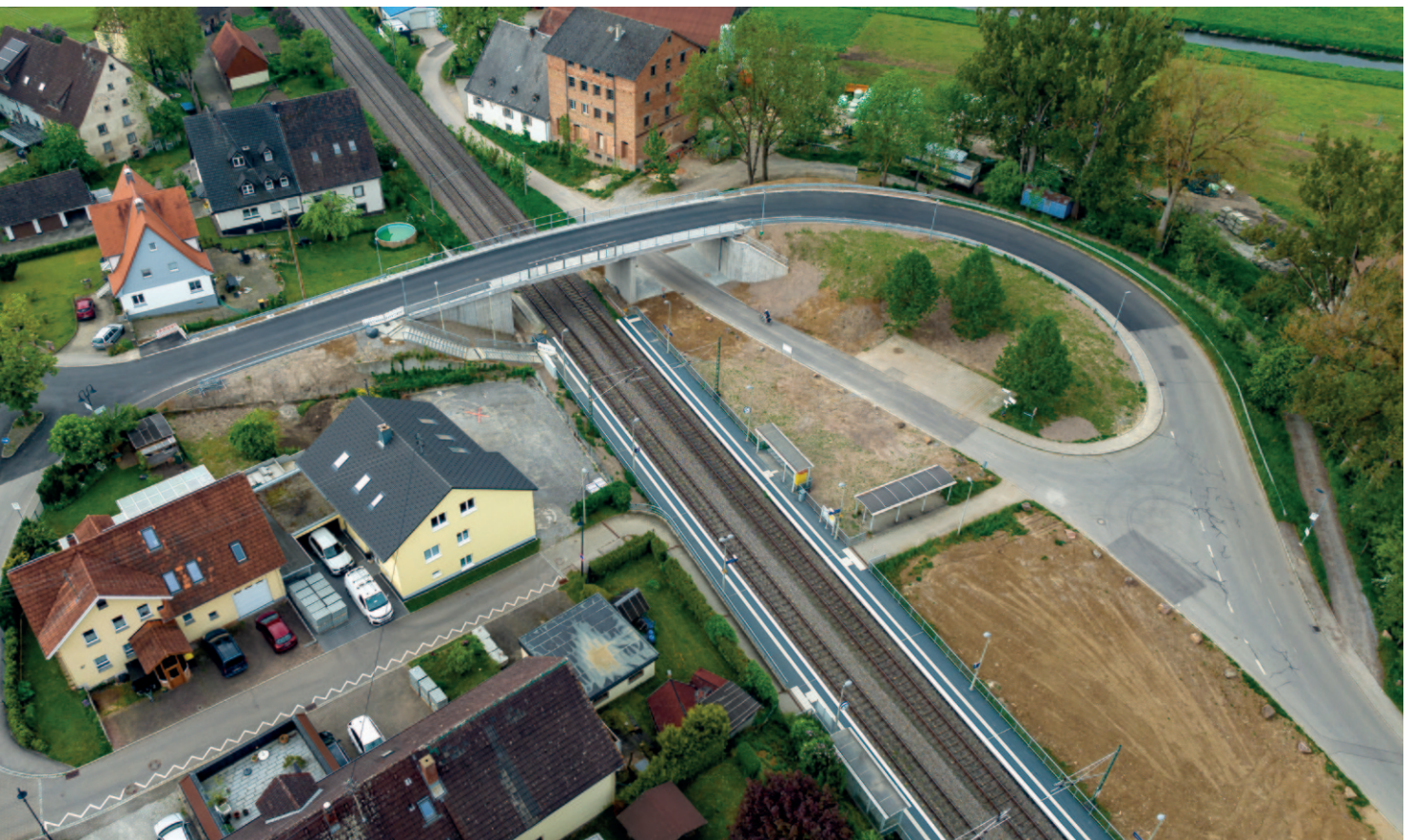
Fertiggestellte Mühlenbrücke (Foto: MediaProd)
