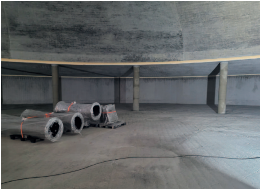
TWL TWB3 – Untergrundvorbereitung nach Strahlen und Reinigung
