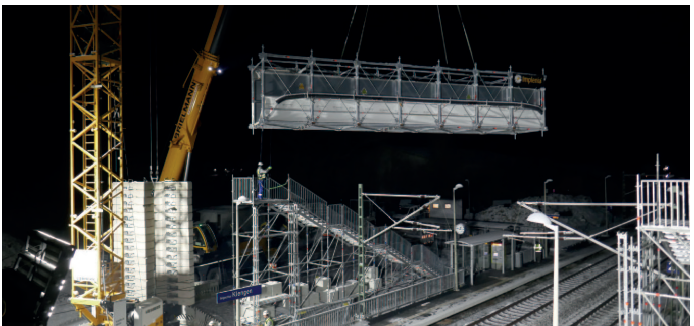
Abriss Behelfsbrücke (Foto: Jörg-Dieter Klatt)
