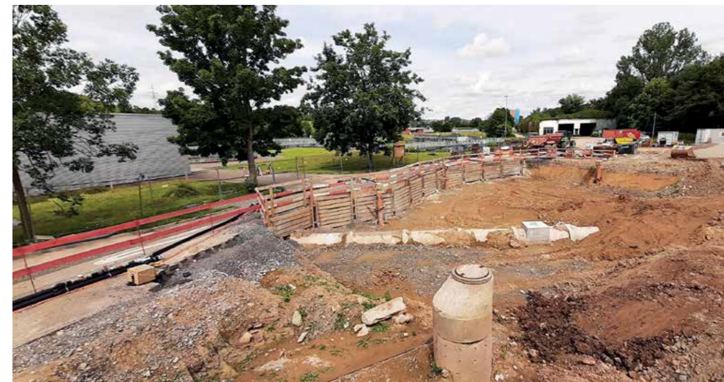
Baufortschritt am Hauptklärwerk Stuttgart
