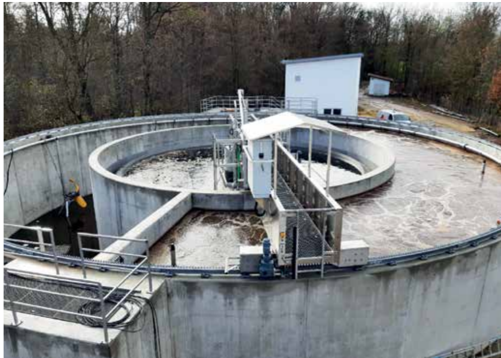
Blick auf das neue Kombinationsbecken der Kläranlage Oberndorf
