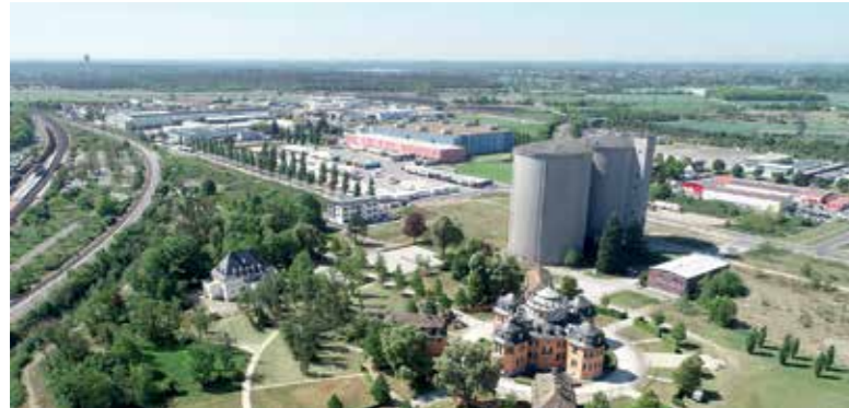
Zuckersilos vor dem Abbruch; Bildquelle: ip roth
