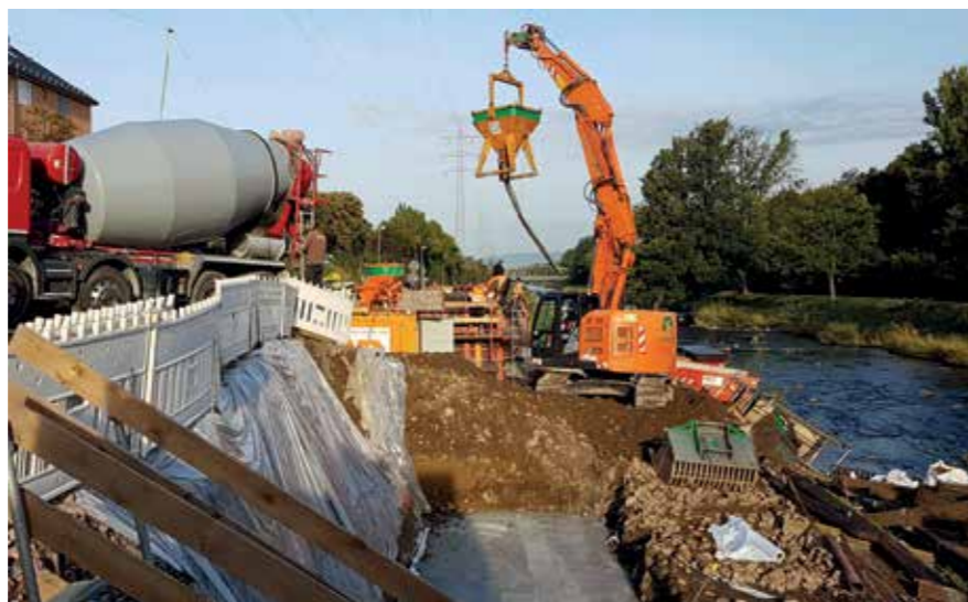
Beengte Platzverhältnisse als Herausforderung
