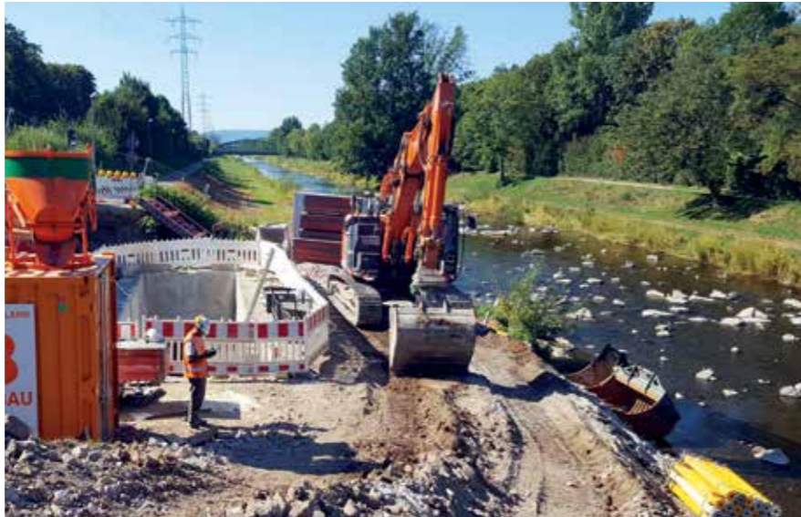
Bauarbeiten angrenzend an die Dreisam
