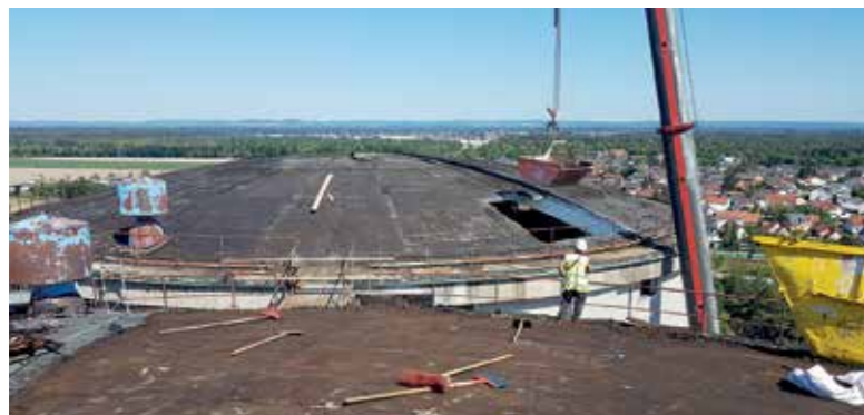
Demontage des Dachaufbaus und Materialtransport mit Mobilkran
