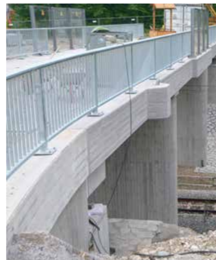
Fertig gestellte Straßenbrücke Haltingen
