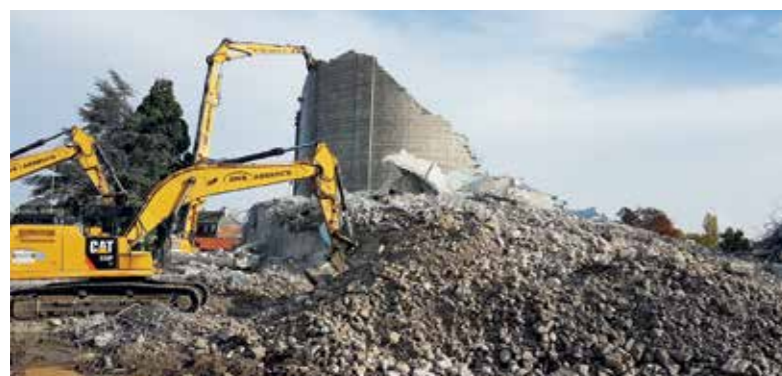
Abbruch mit Longfront- und Abbruchbagger
