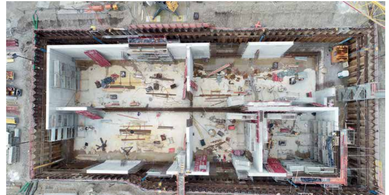
Belebungsbecken mit einer Wandstärke aussen von 60 cm und 560 t verlegtem Stahl, Bildquelle: Gebr. Schmöglz GmbH & Co. KG
