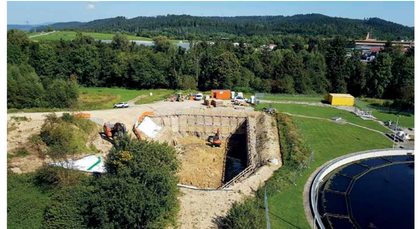
Baugrubenherstellung GAK-Filter Deißlingen
