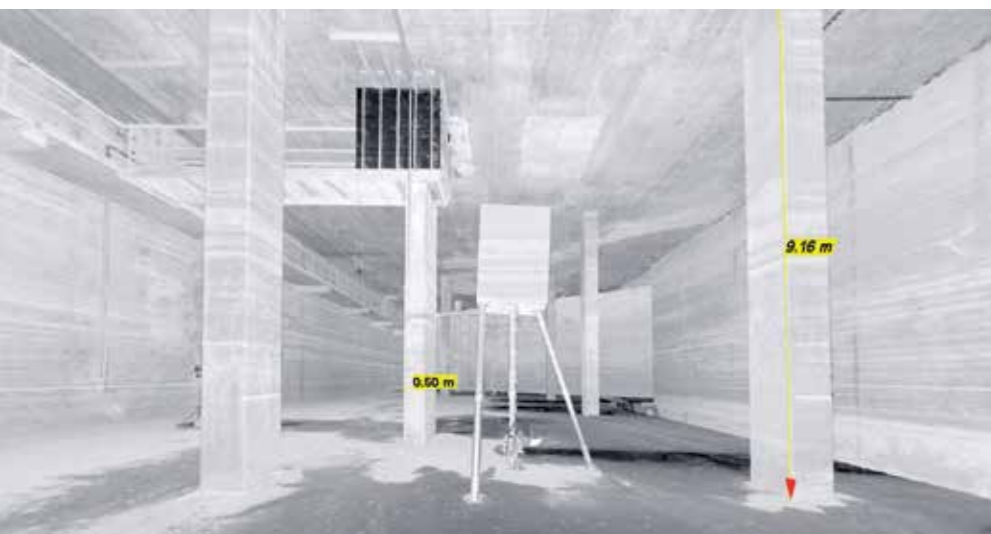
Digitale Ansicht des Regenrückhaltebeckens
