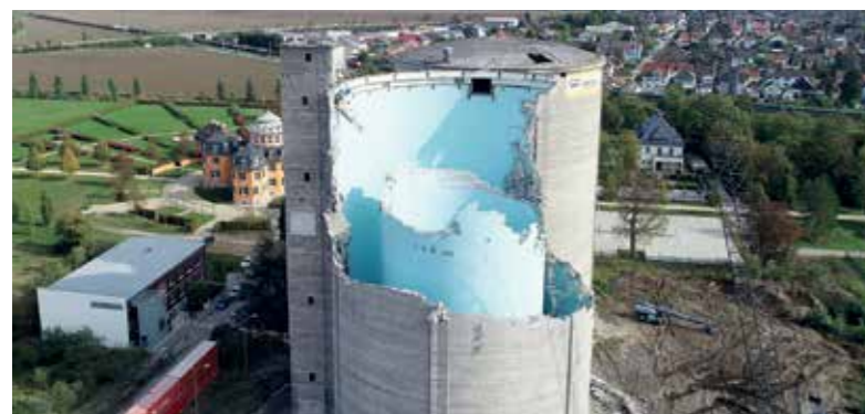
Abbruch mit Seilbagger; Bildquelle: ip roth
