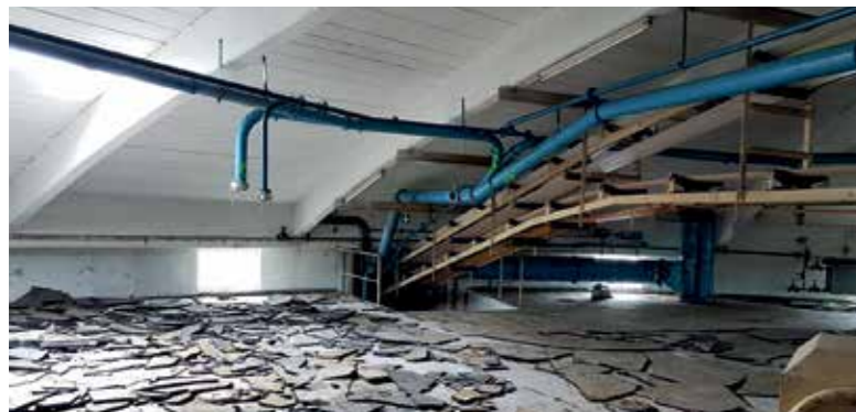
Demontage des Bodenbelags
